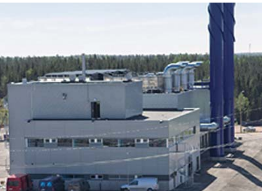
The gas-engine power plant (Ämmässuo).
